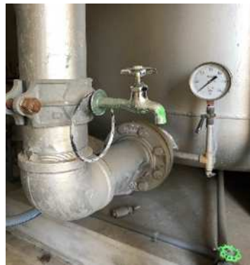
【循環ろ過装置の採水栓】
